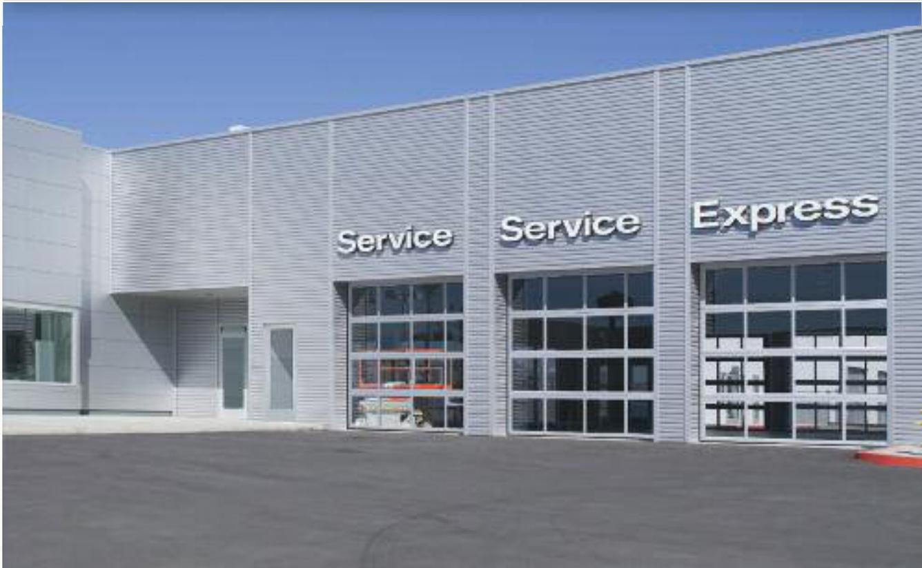
Industrijska dvižna vrata so izdelana po meri. Segmenti vrat so sestavljeni iz jeklene pocinkane pločevine in vmesne izolacijske poliuretanske mase debeline 4 cm. V prostorih, kjer želimo preko vrat pridobiti čim večjo prepustnost svetlobe, vam ponujamo industrijska vrata Full Vision.
