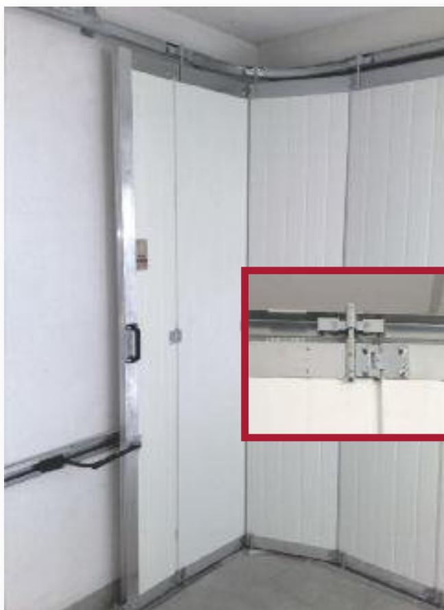
Stranska drsna vrata so primerna predvsem za nizke garaže ali za garaže, ki imajo v notranjosti na stropu določene ovire. To so lahko razne cevi, prečni nosilci ali luči, ki preprečujejo dvžnim vratom pomik pod stropom garaže. Izdelujemo jih po meri, dostavimo in zmontiramo jih na obstoječo odprtino, pri čemer gradbena dela niso potrebna.
